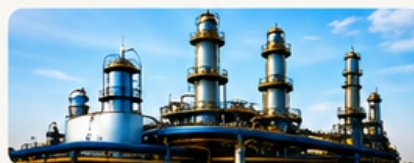
INDUSTRIAL CORRIDOR (TAPPAL-BAJANA)
